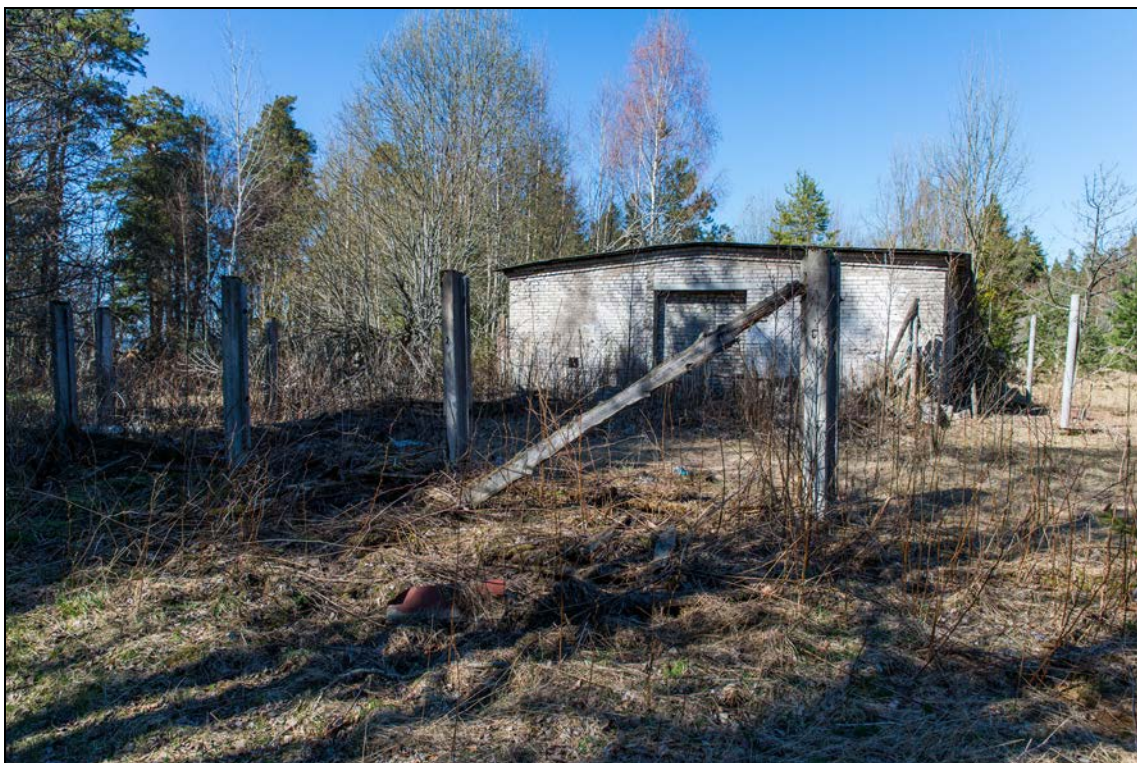
Foto 18 (1364). Lobi raketibaasi linnak. Garaaž / katlamaja [6], vaade [16] suunast. Foto Mart Mõniste 24.04.2014.
