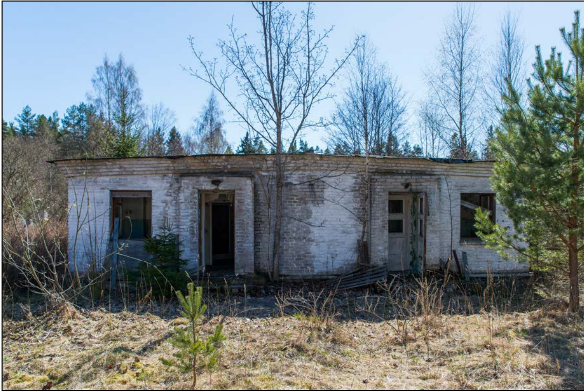
Foto 9 (1316). Lobi raketibaasi linnak. Peahoone [1] otsas on kaks eraldi sissepääsuga korterit, vaade [2] suunast.
