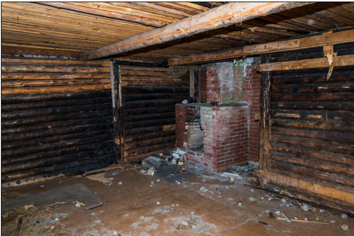
Foto 48 (1402). Lobi raketibaasi linnak. Sauna [14] palkseintel on tulekahju jäljed, väljas on silikaattellistest vooder. Foto Mart Mõniste 24.04.2014.
