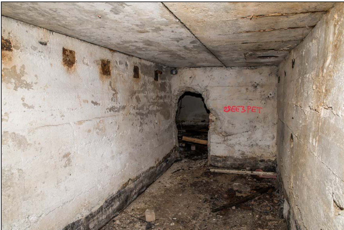
Foto 30 (1382). Lobi raketibaasi linnak. Kelder [8]. Raketibaaside ehitised on tavaliselt ümberehitusjälgedega, siin on koguni keldri betoonseinast uks läbi murtud. Foto Mart Mõniste 24.04.2014.
